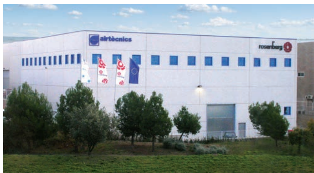
Главный офис Airtènnics в Каstellаре-дель-Вальес (Испания)
