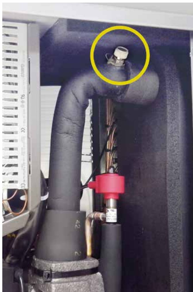
Вентиляционные клапаны, monobloc версия.
